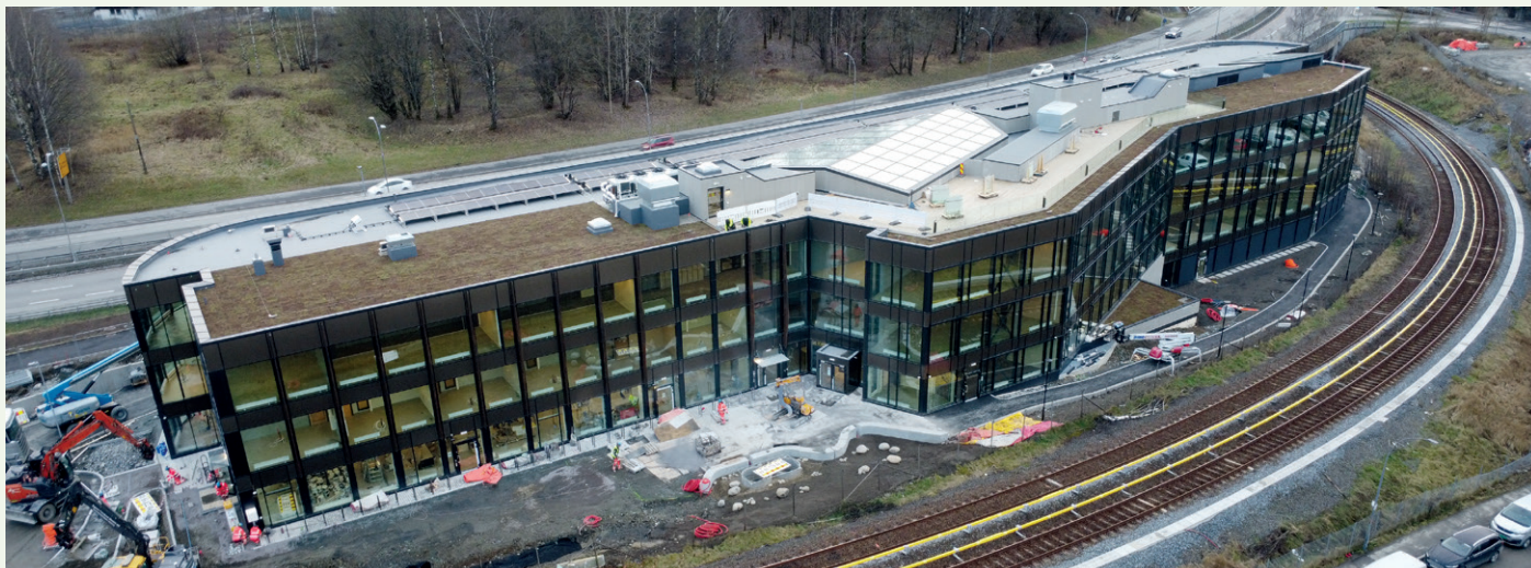
Bygget har riksvei 4 på den ene langsiden og T-banelinjen på den andre.
