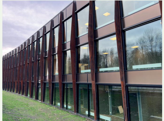
På fasaden er det satt opp en rekke finner av cortenstål som danner et mønster.
