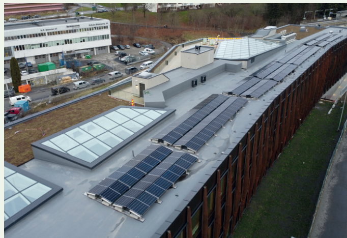
Det er montert en rekke solceller på taket, som også inneholder en takterrasse og sedumbelegg.
